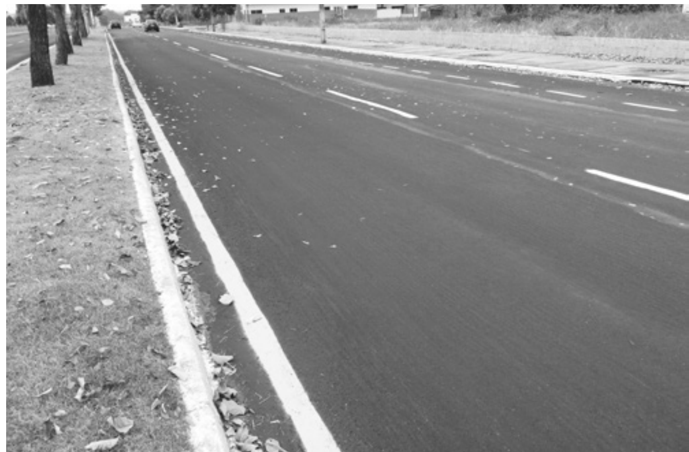
Avenida Brasil está recebendo sinalização de solo
