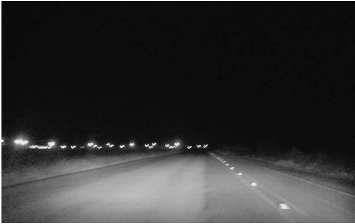
Escuridão na Avenida Alvadi Monticelli
