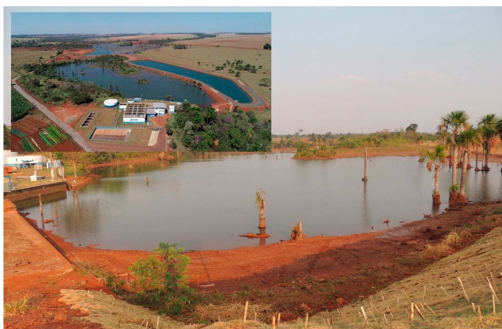
Reservatório do Queima-Pé
