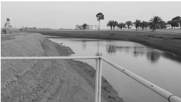
Reservatório do Queima-Pé
