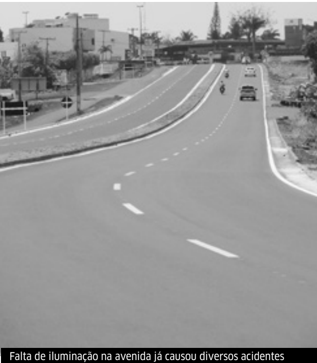
Falta de iluminação na avenida já causou diversos acidentes
