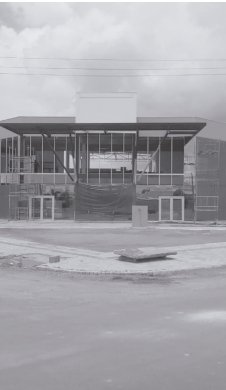
Escola José Delfino, em construção
