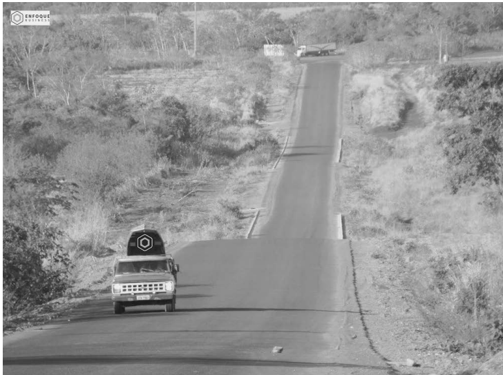
MT-339 conta apenas com um pequeno trecho pavimentado
