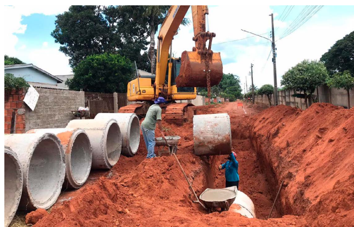
Obras na Estrada do Mituo
