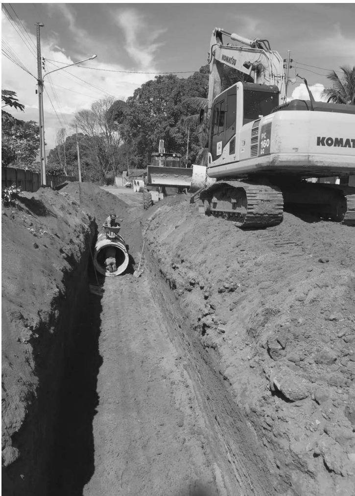
Obras na Estrada do Mitu
