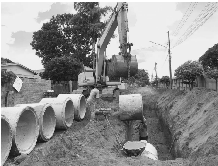
Obras seguem a todo ritmo
