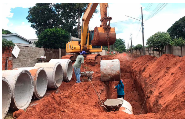
Obras na Estrada do Mituo
