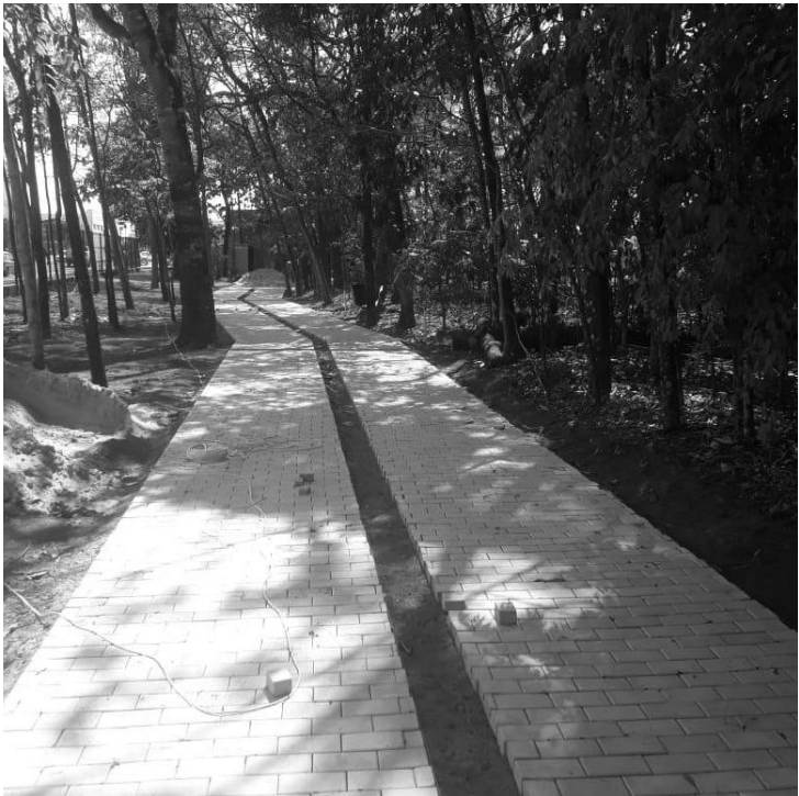
Bosque Municipal está em obras
