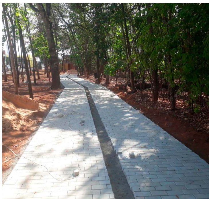
Bosque Municipal está em obras desde setembro
