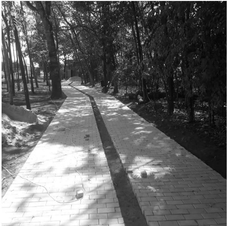
Bosque Municipal está em obras
