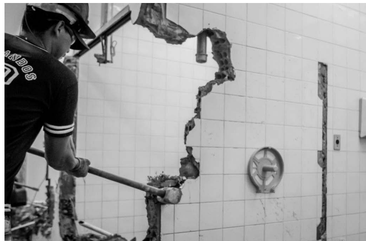
Serão pequenos reparos
