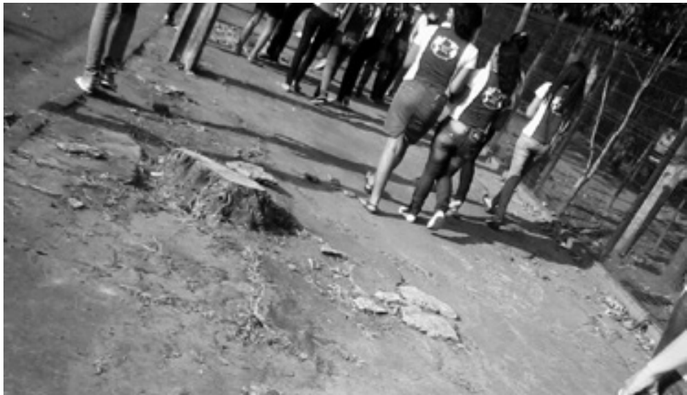
Calçada quebrada e pedaço de tronco foram encontrados próximo do Bosque Municipal
