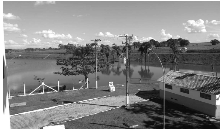
Estação de Tratamento nesta terça, dia 28
