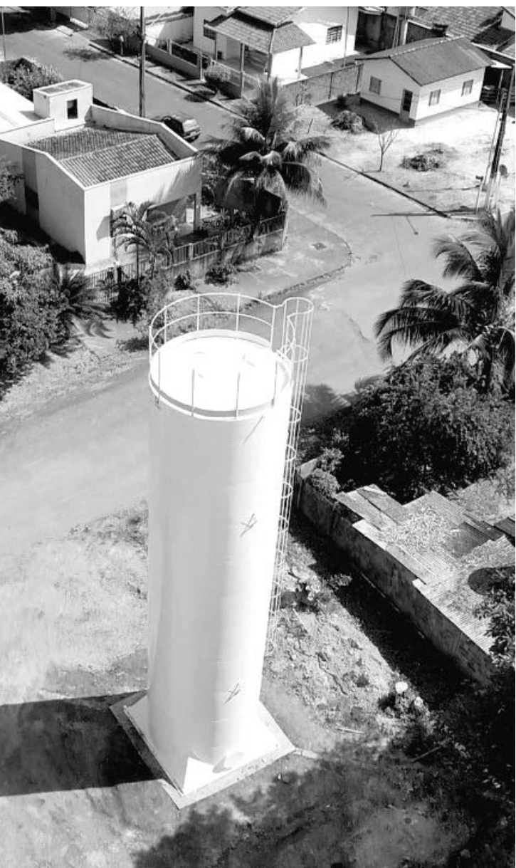
Reservatório na Vila Nazaré
