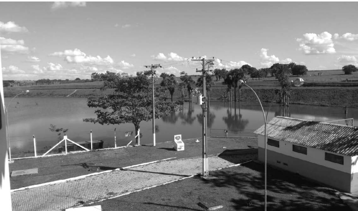
Estação de Tratamento nesta terça, dia 28
