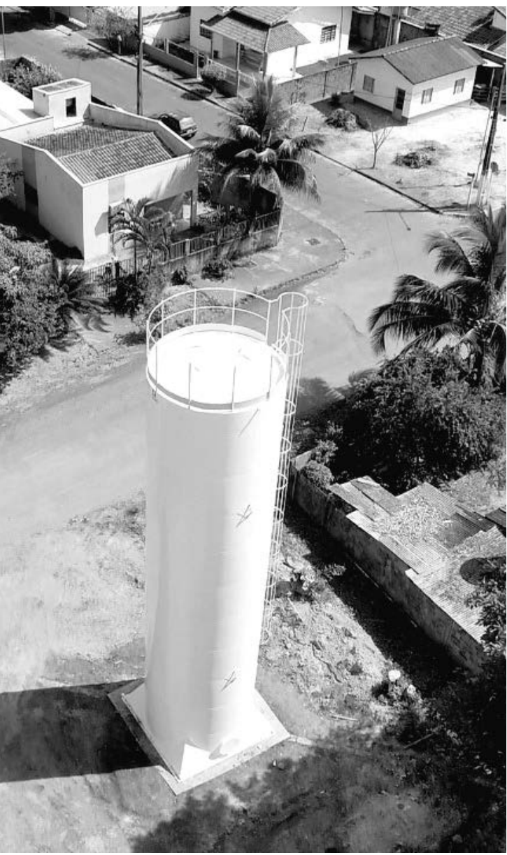
Reservatório na Vila Nazaré
