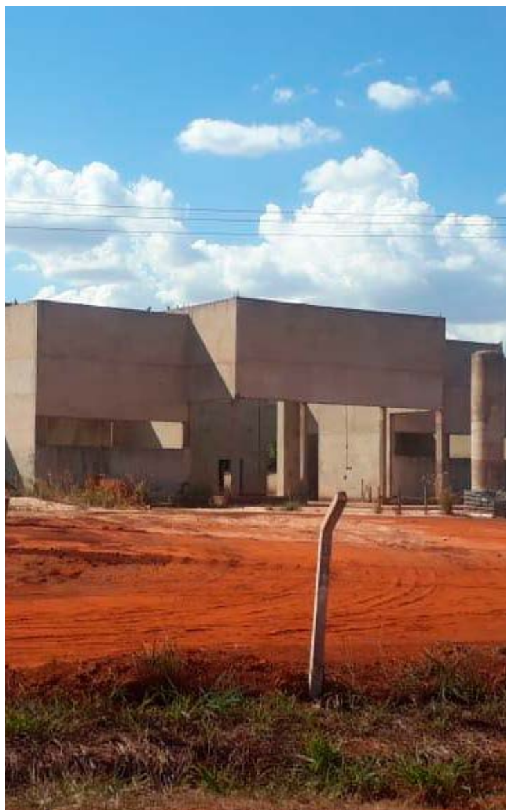
Obra estava paralisada
