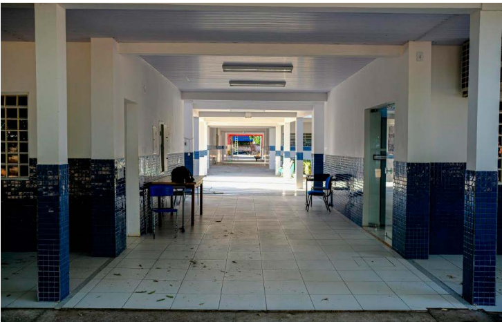
Reforma geral da EE Julio Muller
