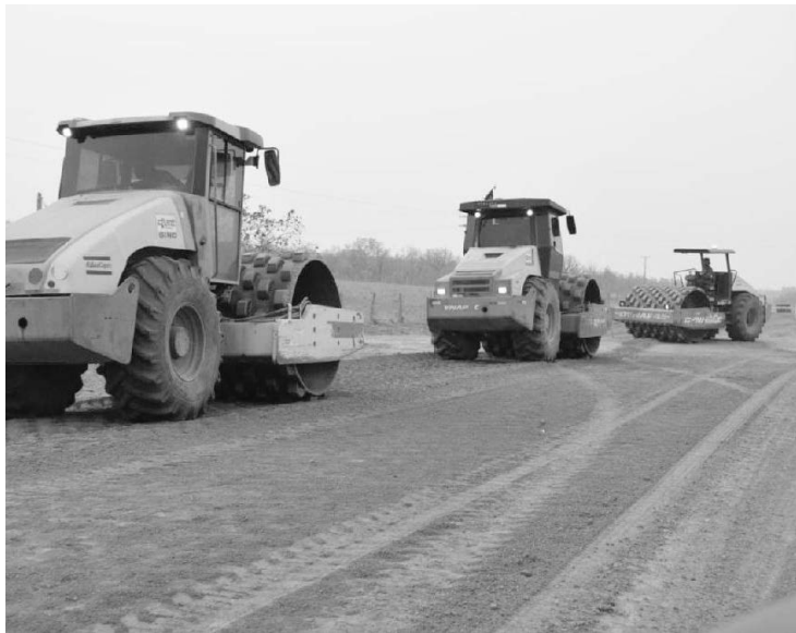
Obras vistoriadas pelo Secretario da Sinfra
