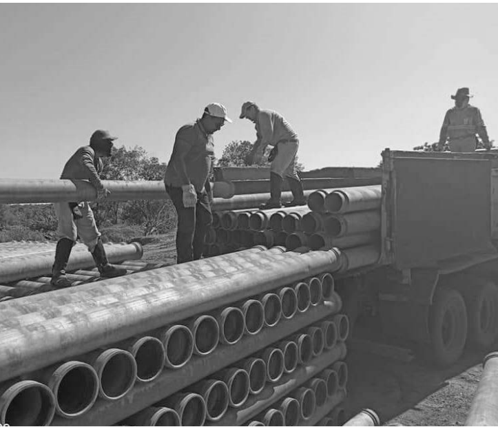
Transporte dos tubos e equipamentos
