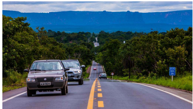
Rodovia MT 251 Chapada
