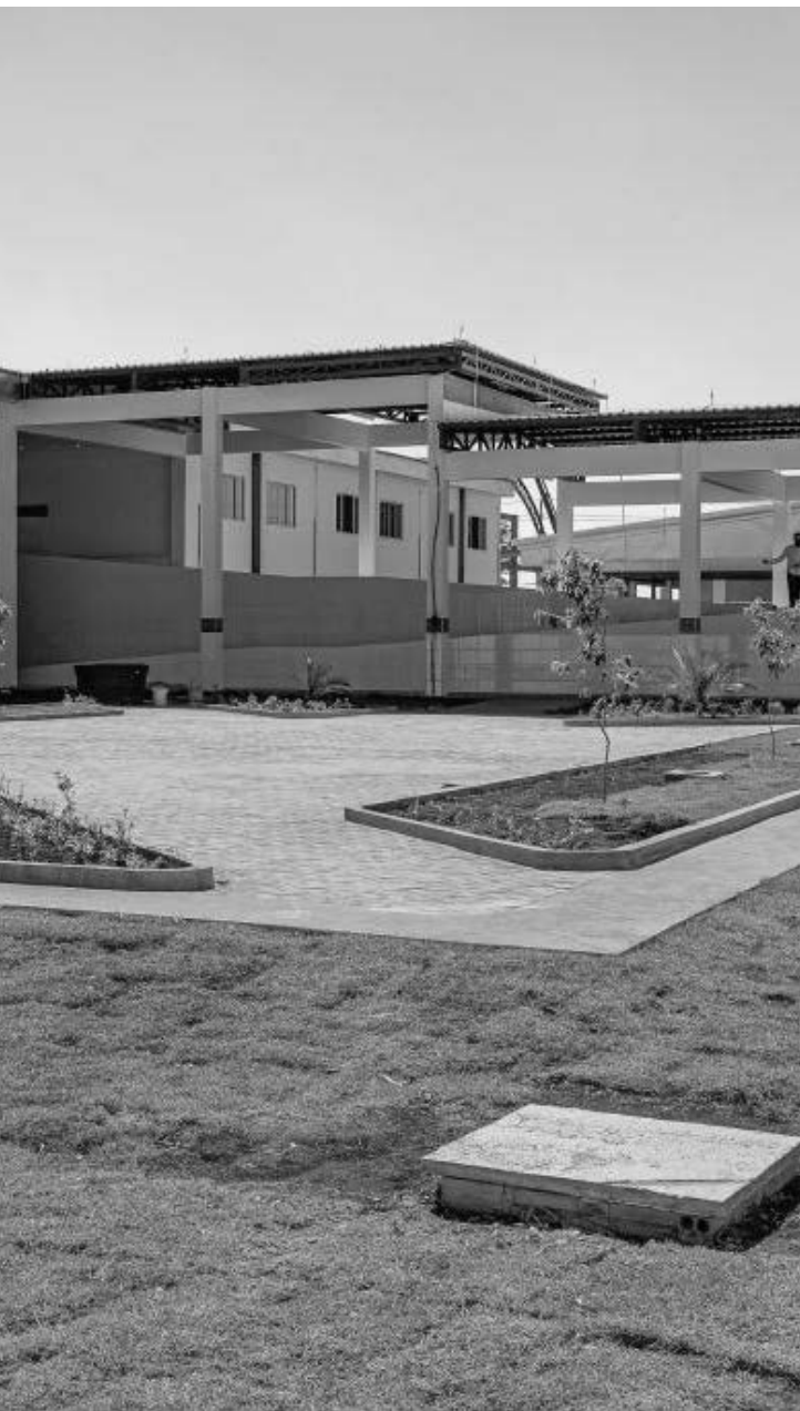
Aulas na Bento Muniz serão em nova estrutura
