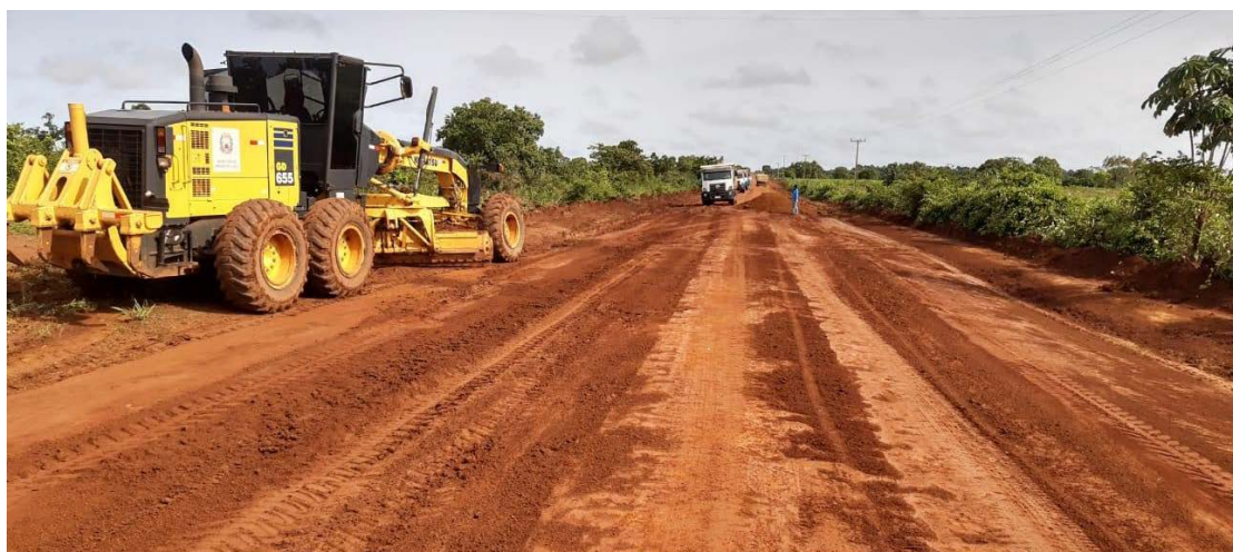
Manutenção das estradas não pavimentadas
