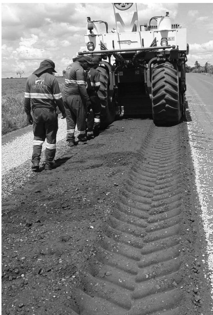
Trecho em obras
