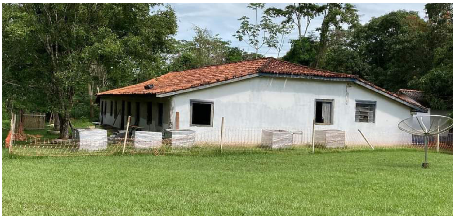
Casa de Rondon está recebendo melhorias
