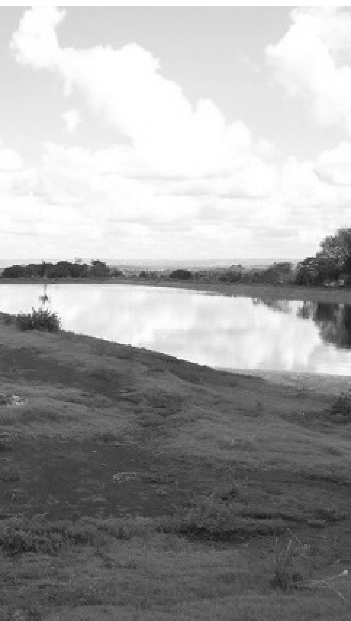
Estação de Tratamento de Esgoto
