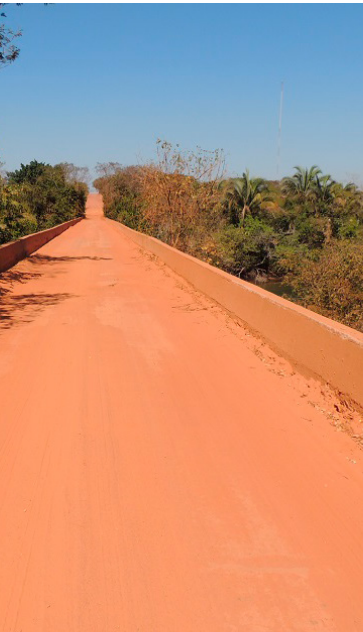
Ponte sobre o rio Sepotuba, em Nova Fernandópolis
