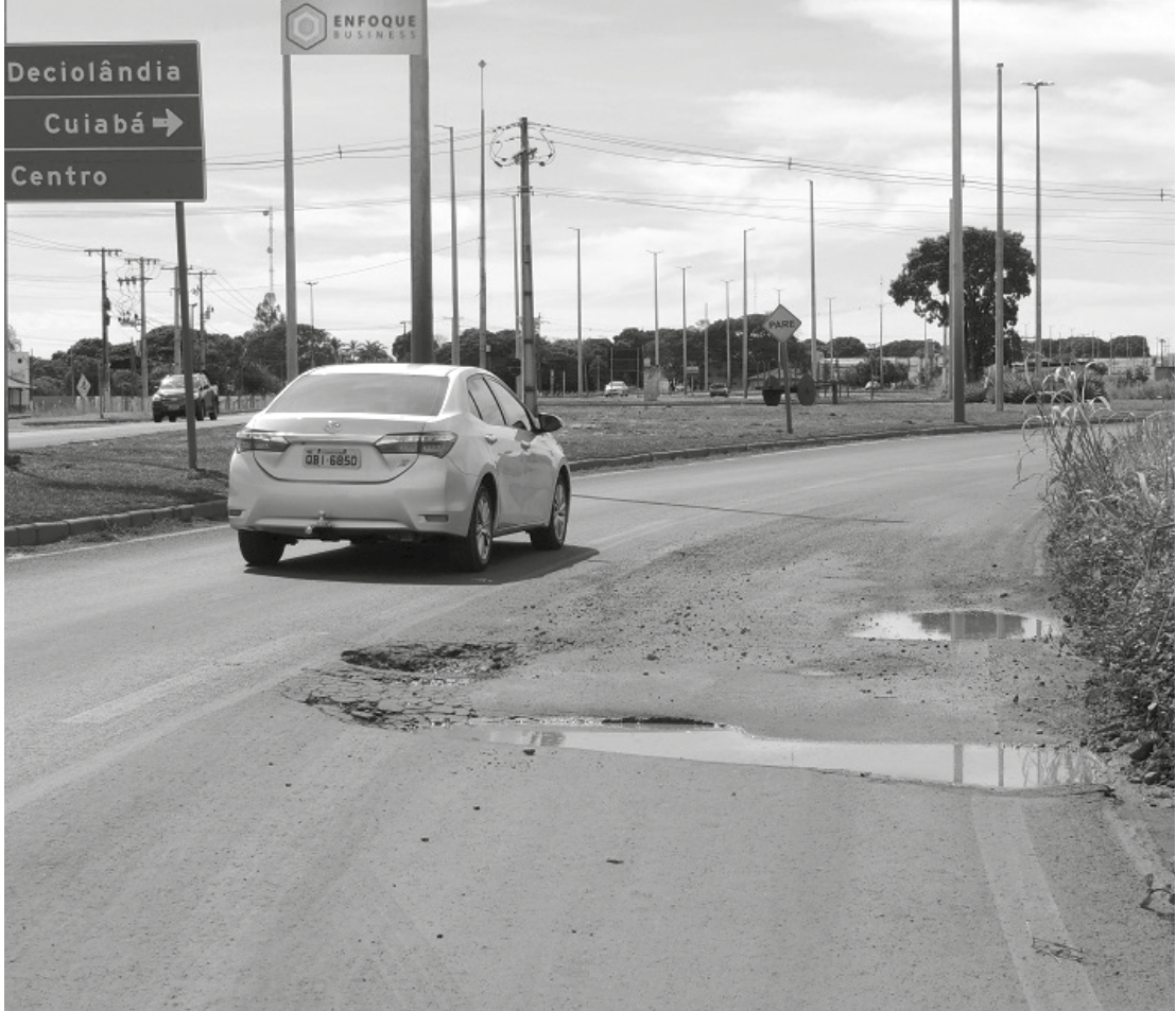
Buracos e deteriorações prejudicam tráfego e oferecem riscos
