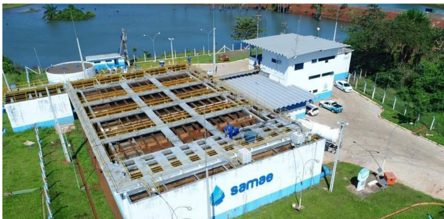
Estação de Tratamento de Água (ETA) será ampliada
