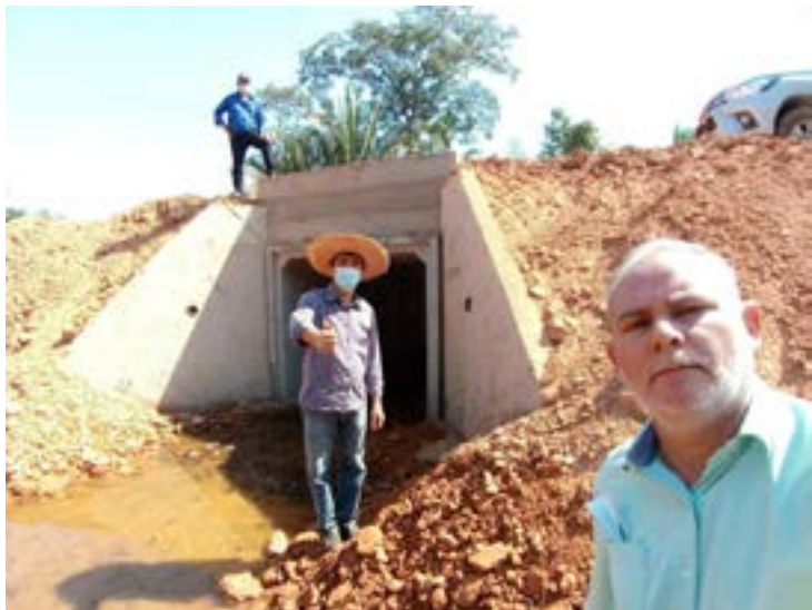
Vistoriaram obras que estão sendo executadas
