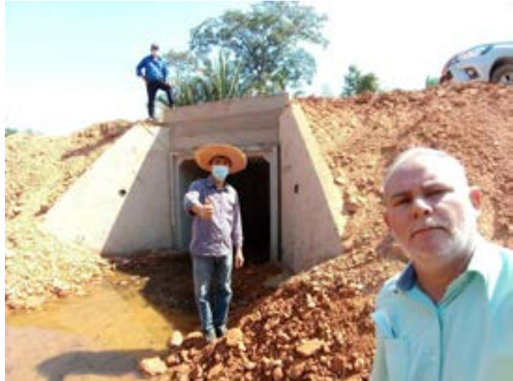
Vistoriaram obras que estão sendo executadas
