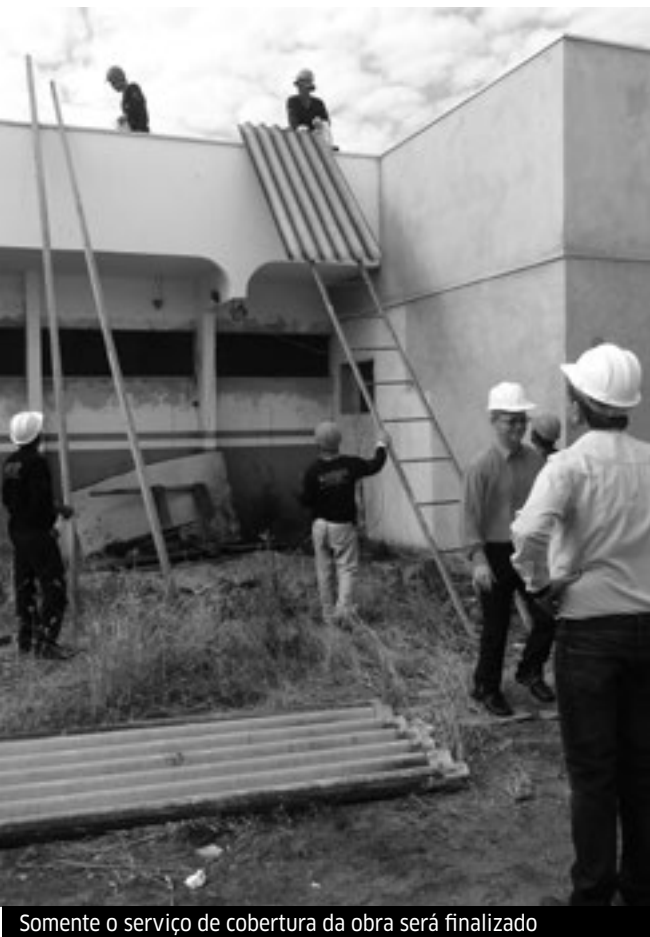
Somente o serviço de cobertura da obra será finalizado
