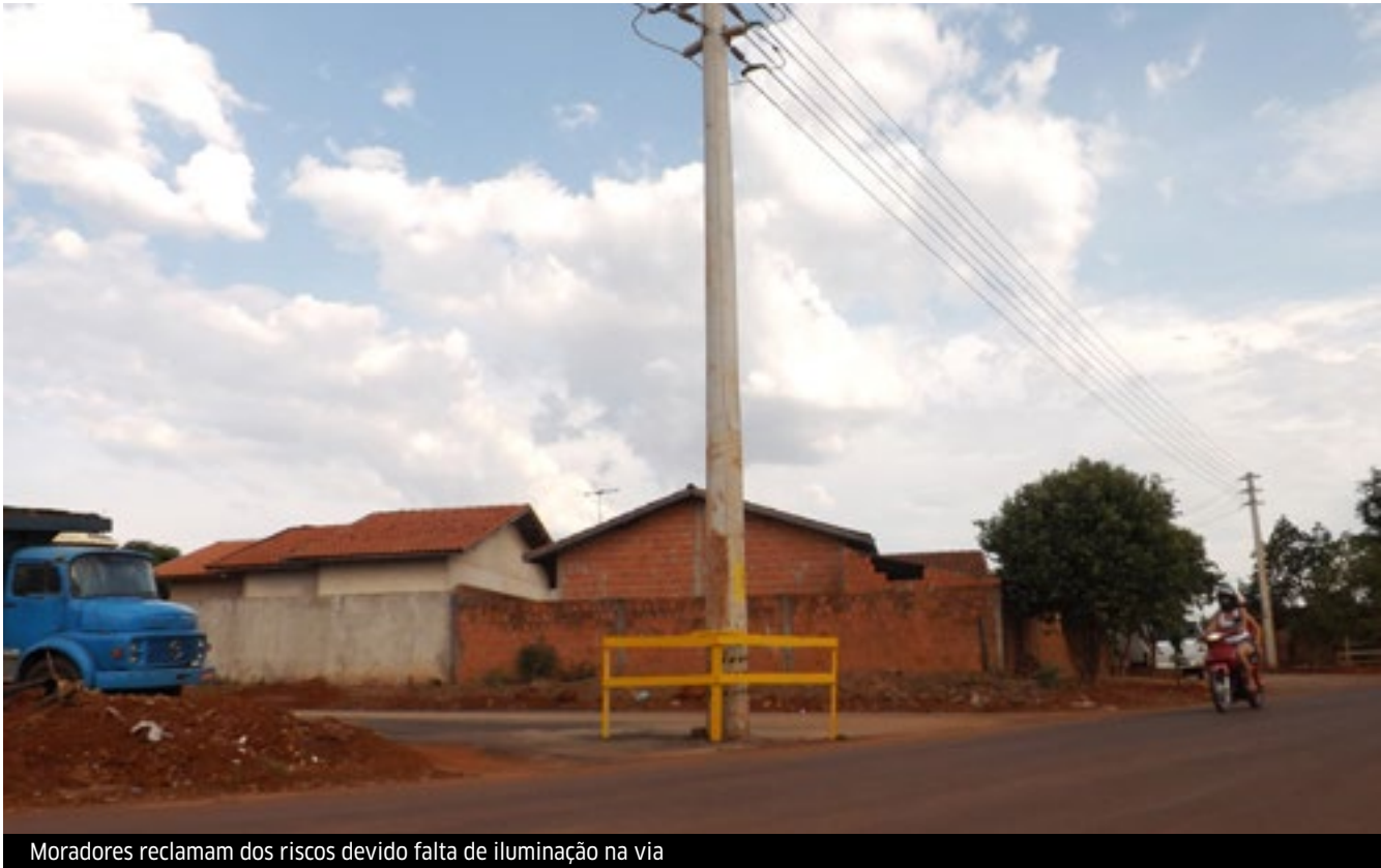
Moradores reclamam dos riscos devido falta de iluminação na via
