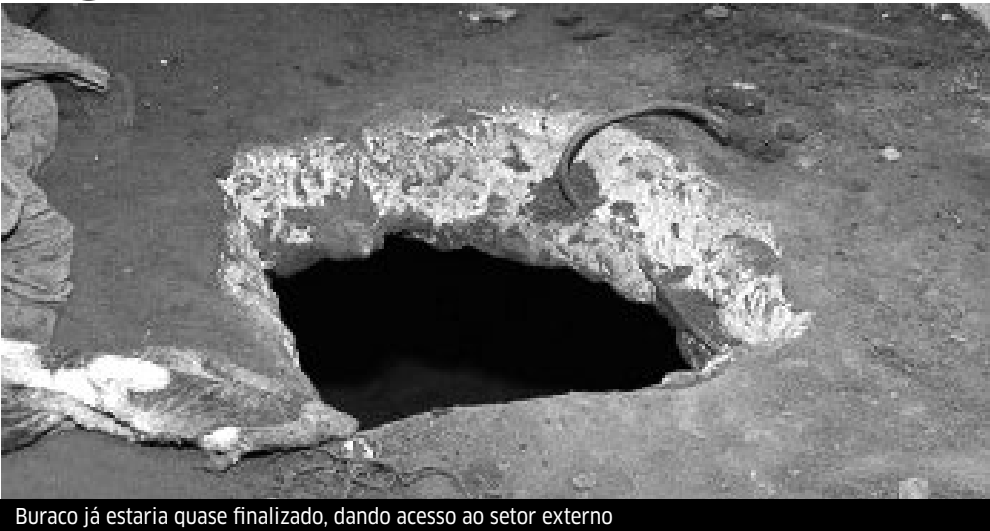
Buraco já estaria quase finalizado, dando acesso ao setor externo
