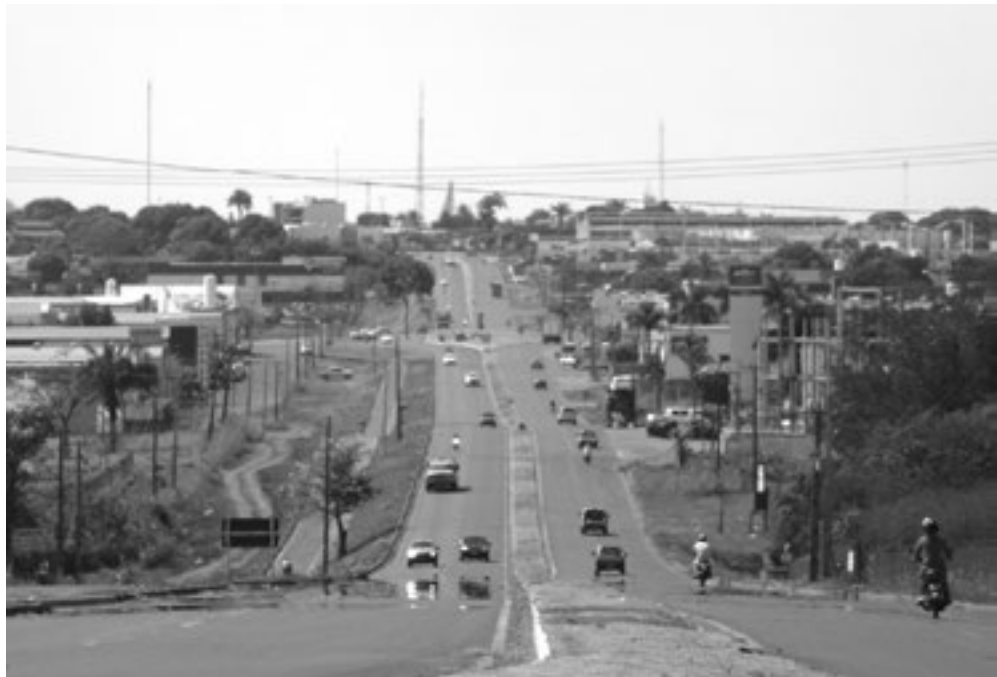
Algumas adequações precisam ser feitas para que projeto seja concluído
