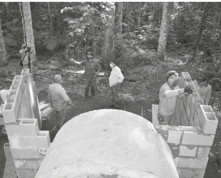
Implantação de tubulação
