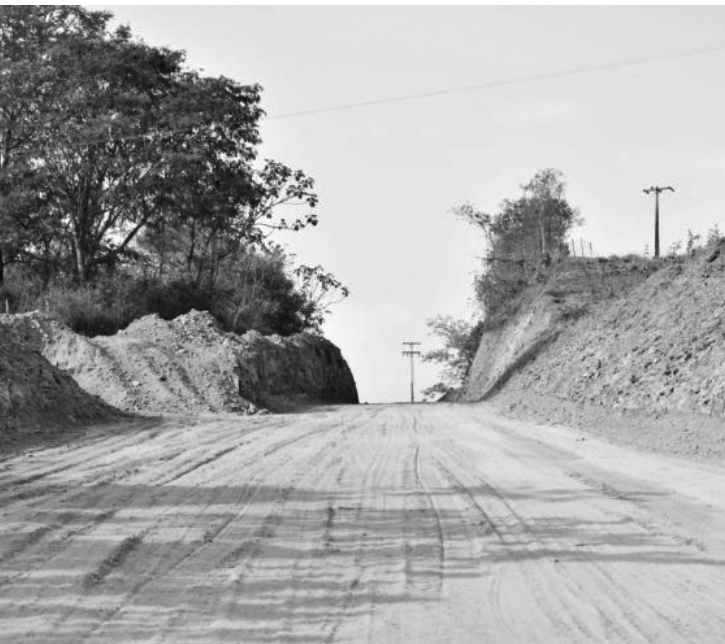
Obras em andamento
