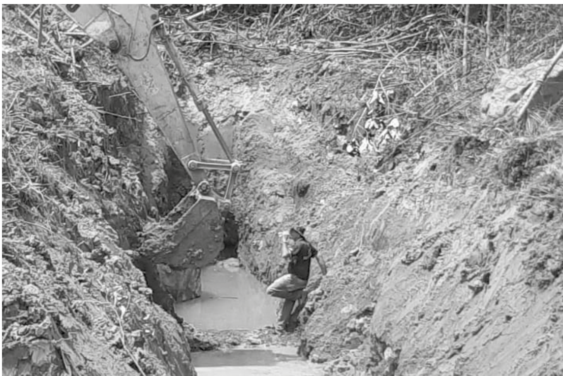
Trabalho de recuperação da nascente do Rio Queima Pé
