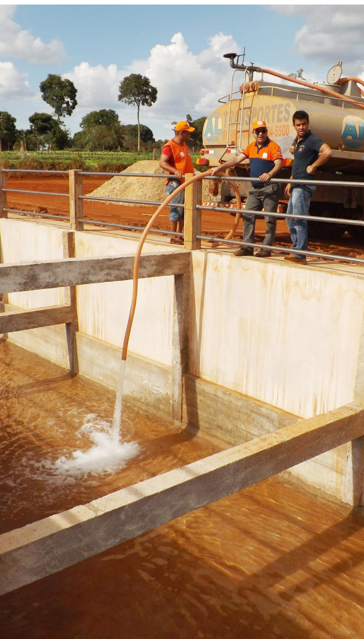
Caminhões serão usados para transporte de água bruta
