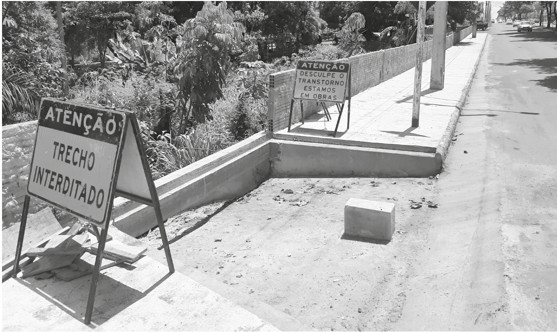
Canteiro de obras foi instalado na Avenida Nilo Torres
