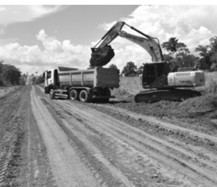
Estrada aberta e bueiro construído
