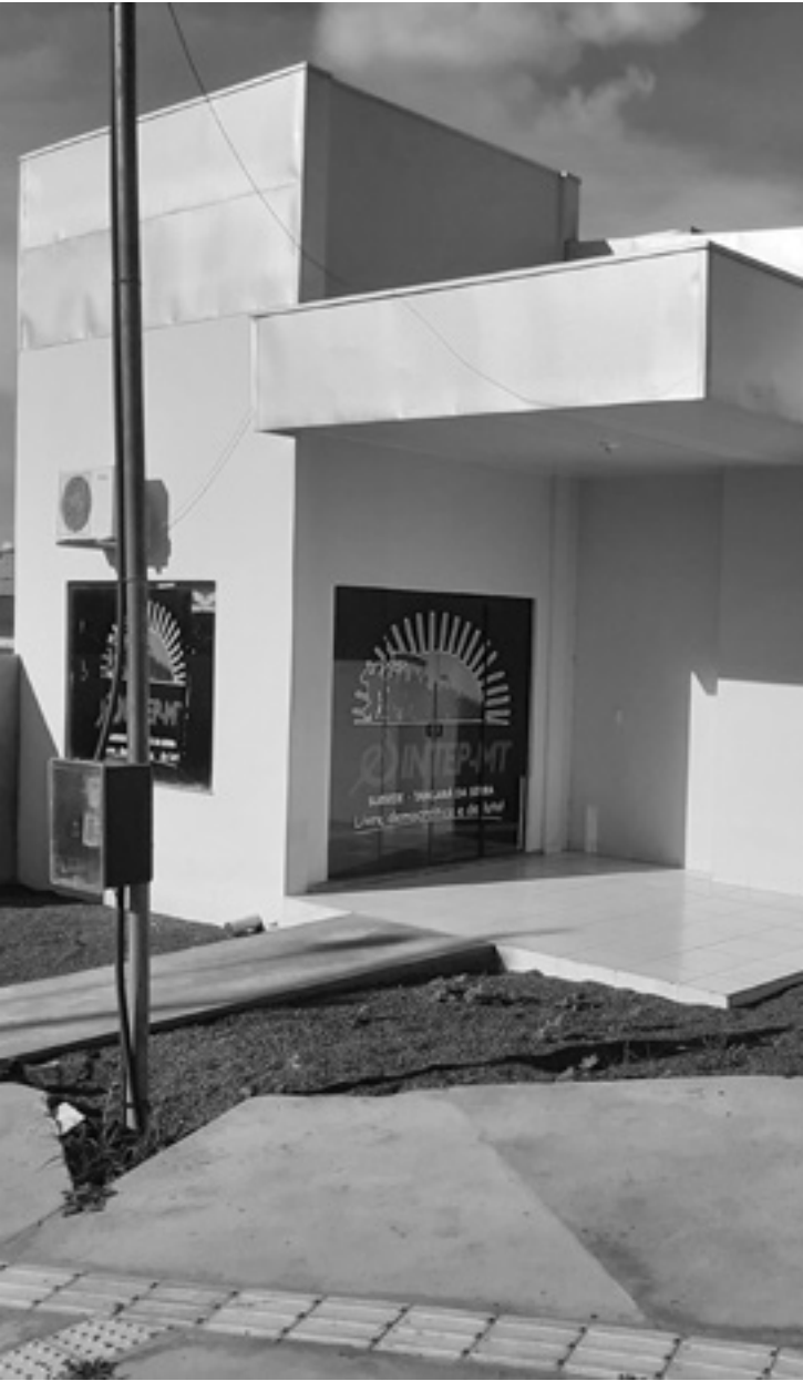
Prédio praticamente finalizado
