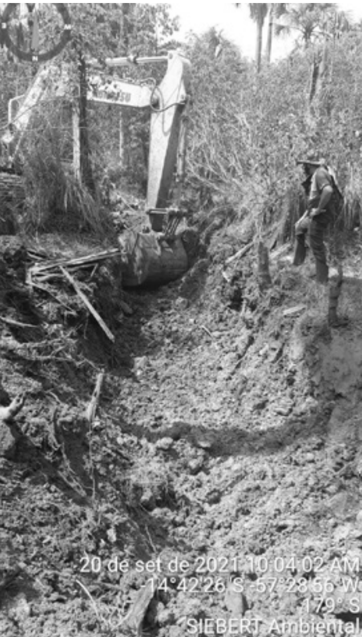
Trabalho realizado na nascente do Queima Pé
