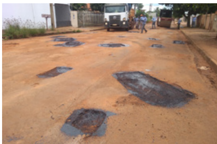
Sinfra e Samae estão atuando nas frentes de trabalho
