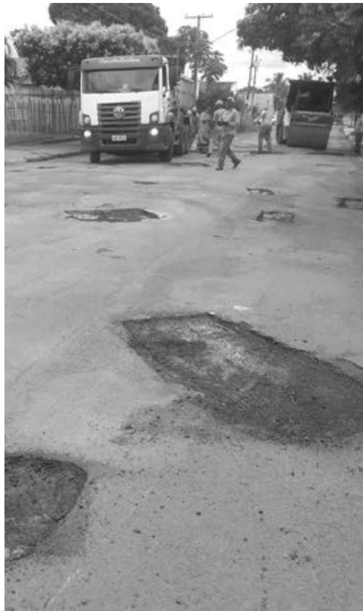
Sinfra e Samae estão atuando nas frentes de trabalho
