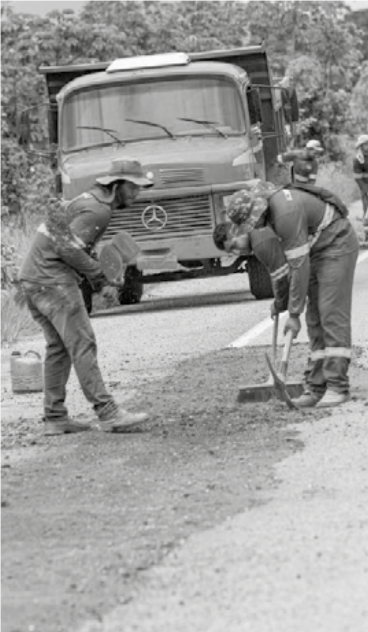
Obras de Restauração na MT-343
