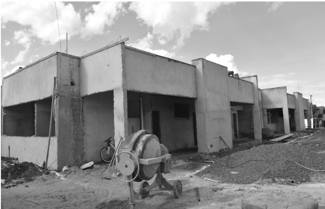
Obras da Creche do Jardim dos Ipês já estão avançadas
