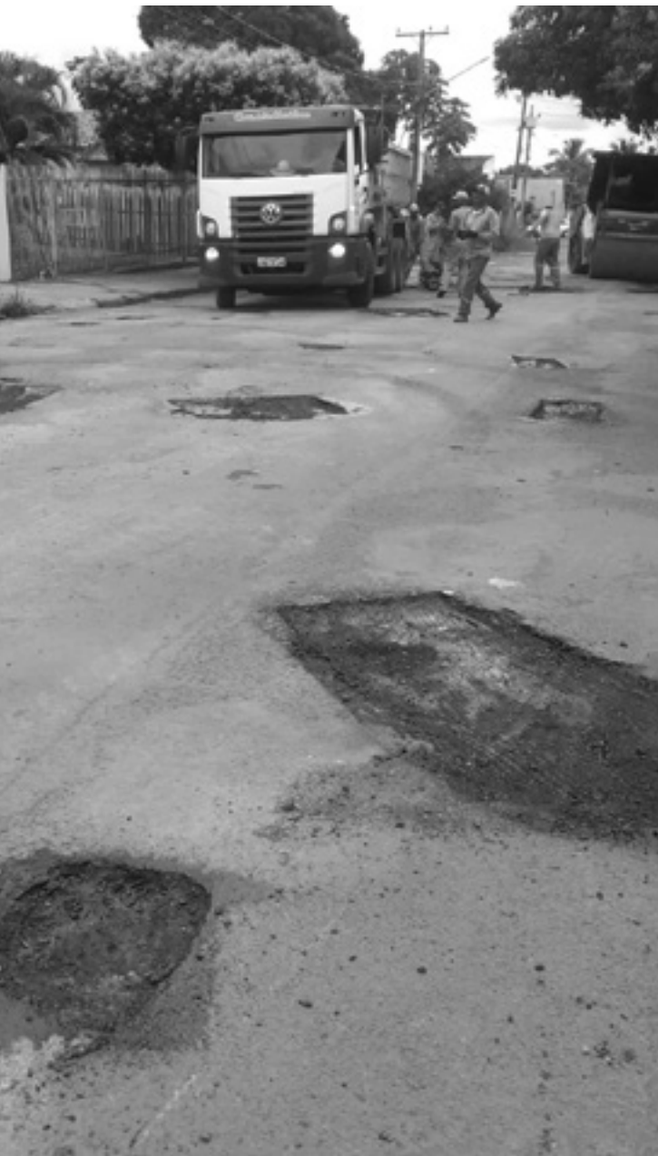
Recuperação da pavimentação
