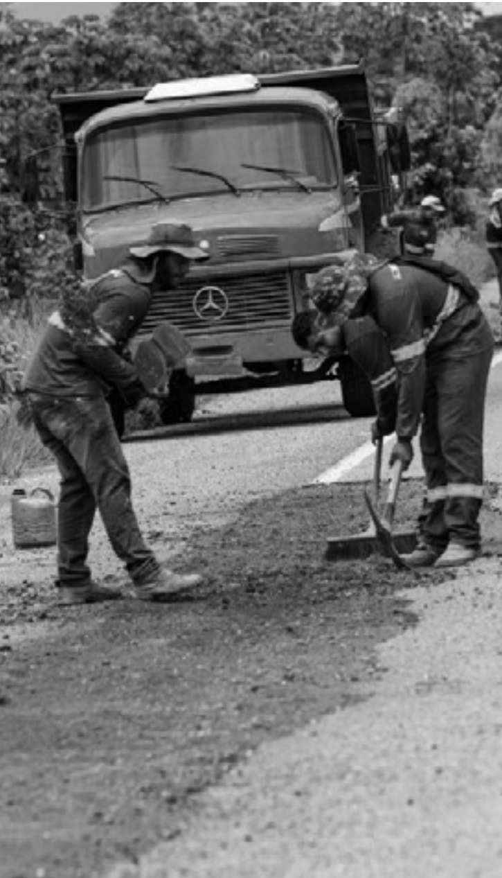
Obras de restauração em Mato Grosso
