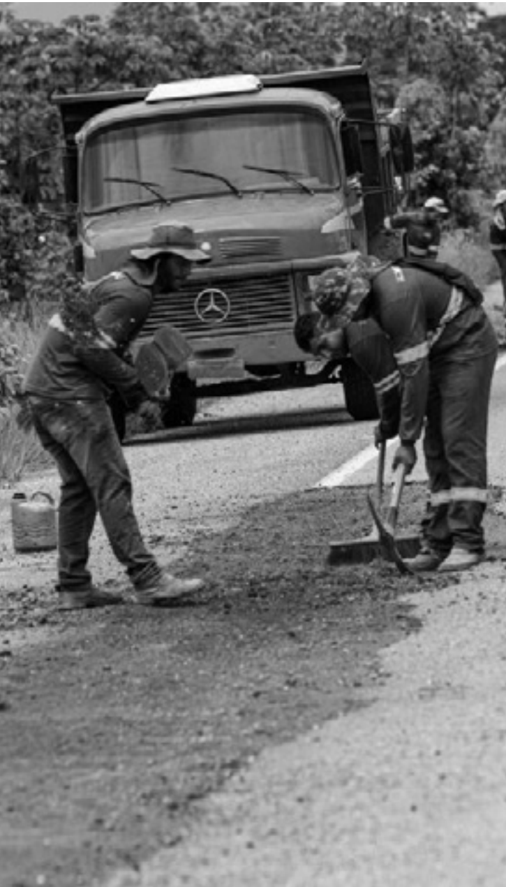
Obras de restauração em Mato Grosso
